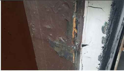
Hanger 4 Door 2 Casing – Side D
